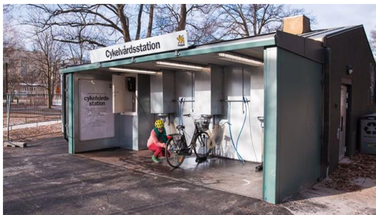
Figur 3-3 Cykelvårdsanläggning i Uppsala kommun (källa: https://www.svt.se/nyheter/lokal/uppsala/uppsalas-forsta-cykelvardsstation-ar-fardig )
